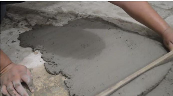
2. Se prepara la base donde se va a realizar la instalación, esta debe quedar debidamente nivelada.
