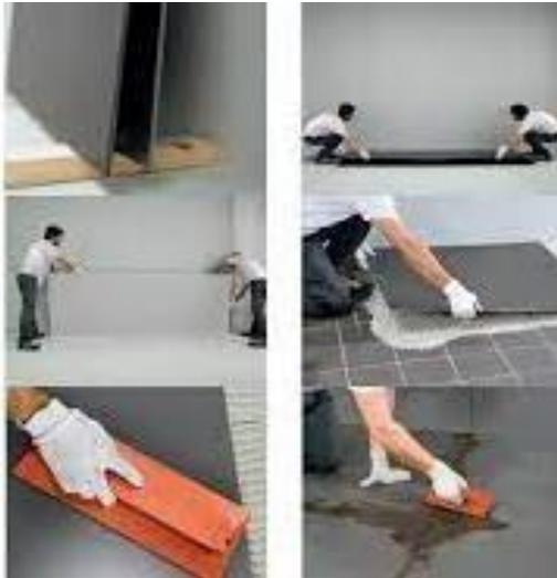
5. Se procede a colocar el piso sobre el adhesivo utilizado y posterior se le aplica la boquilla, que es el material que va en medio de los pisos y luego se limpia para que el pigmento de la boquilla no manche el piso.
