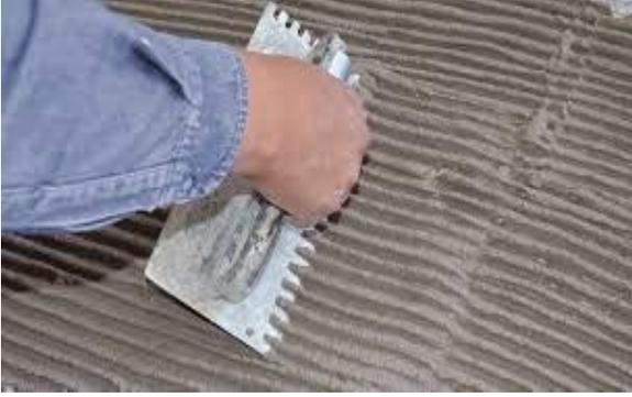
3. Se aplica el adhesivo recomendado por el fabricante, no utilizar cemento y arena.
